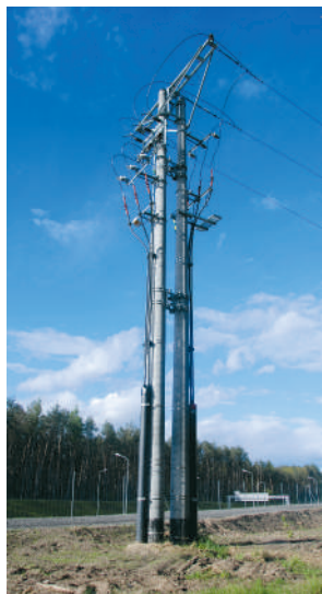
Stanowisko średniego napięcia na żerdziach wirowanych typu E
