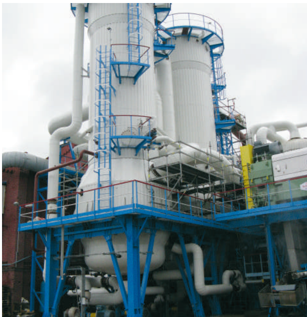
Modernizacja gospodarki cieplnej w Cukrowni Nakło
