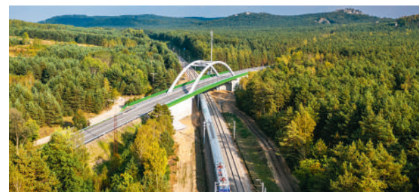
Wiadukt nad torami kolejowymi w ciągu DW 792 w Hucisku
