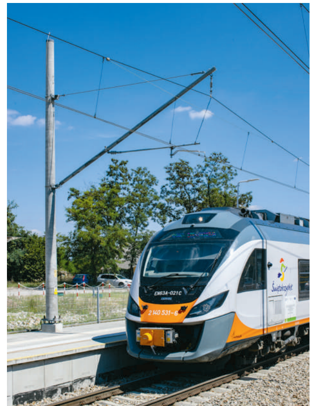
Słup ETG zainstalowany na stacji Czarnca k. Kuzek
