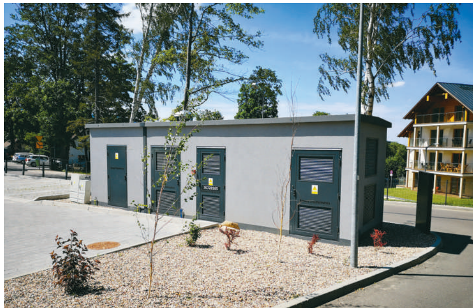
Kontenerowa stacja transformatorowa SN typu KSW
