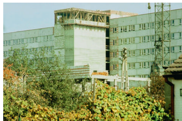
Szpital w budowie (1982-1984)
