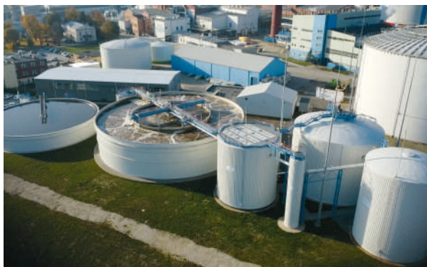
Budowa zakładowej oczyszczalni ścieków przemysłowych w Cukrowni Nakło realizowana przez Techbud-Toruń Sp. z o.o.
