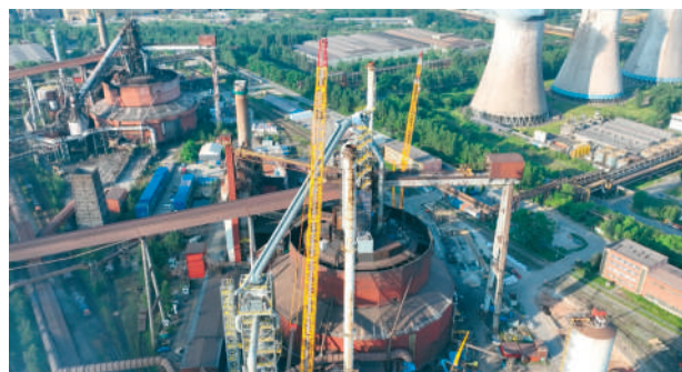
Remont wielkiego pieca dla ArcelorMittal w Dąbrowie Górniczej
