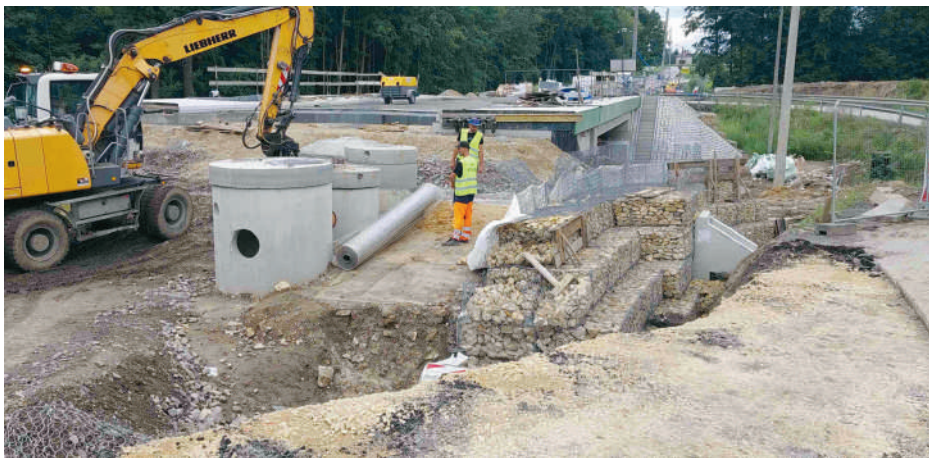
Budowa mostu nad Potokiem Chudowskim w Mikołowie Paniowach
