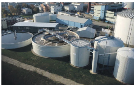
Budowa zakładowej oczyszczalni ścieków przemysłowych w Cukrowni Nakło
