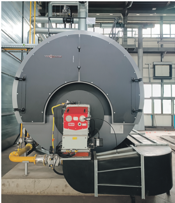
Kocioł wodny z ekomizerem VISSMANN VITOMAX – 300 HW o mocy cieplnej 9,95 MW
