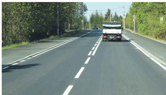
Ormontowice – w-wa ścieralna na TG, CPR i chodnikach, wykonane oznakowanie pionowe i poziome
